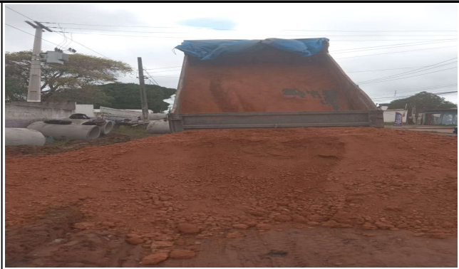
Foto 02 DRENAGEM AV. SÃO SEBASTIÃO VILA NOVA
