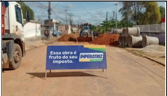
Foto 12 DRENAGEM AV. SÃO SEBASTIÃO VILA NOVA
