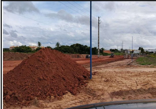
Foto 03 TERRAPLANAGEM AV. QUINTA DO JACO
