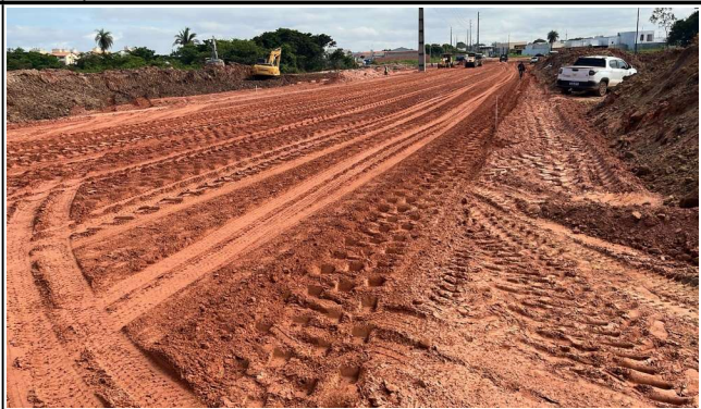
Foto 06 TERRAPLANAGEM AV. QUINTA DO JACO
