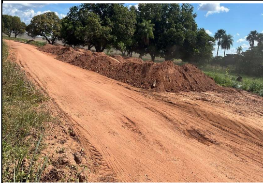
Foto 07 TERRAPLANAGEM AV. QUINTA DO JACO
