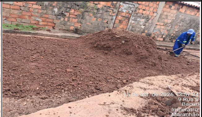
Foto 10 TERRAPLANAGEM RUA BETA BAIRRO BACURI
