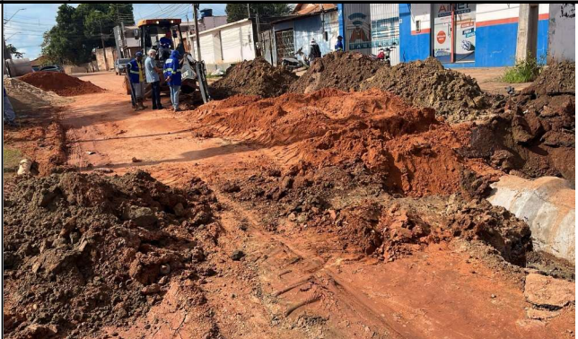
Foto 04 DRENAGEM AV. SÃO SEBASTIÃO VILA NOVA
