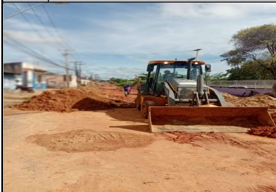
Foto 11 DRENAGEM AV. SÃO SEBASTIÃO VILA NOVA
