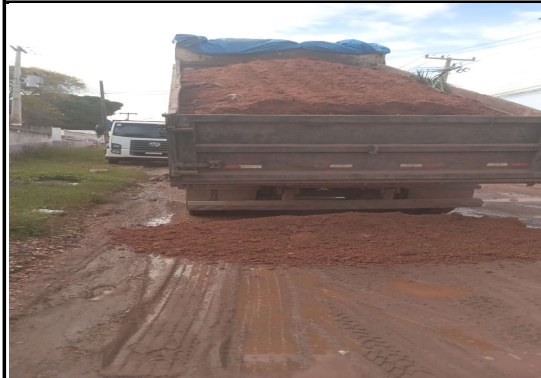
Foto 01 DRENAGEM AV. SÃO SEBASTIÃO VILA NOVA
