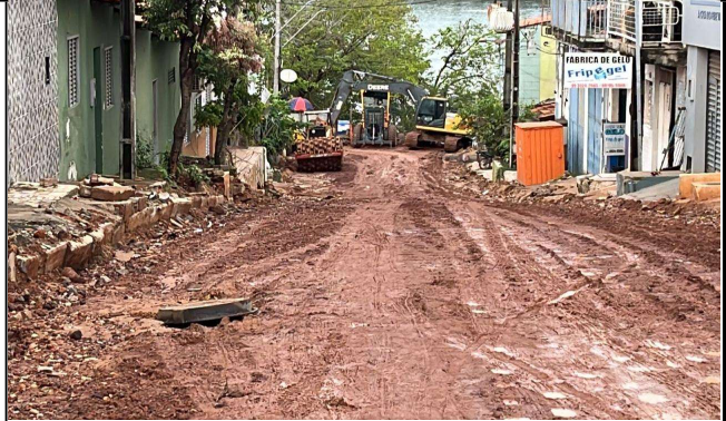
Foto 08 TERRAPLANAGEM GONÇALVES DIAS BEIRA RIO
