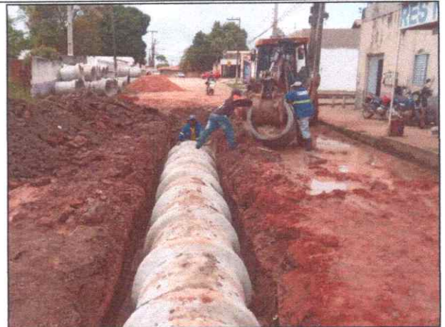
Foto 30 - AV. SÃO SEBASTIÃO - VILA NOVA - TUBO DE CONCRETO ARMADO PA2 - D= 0,80 M.
