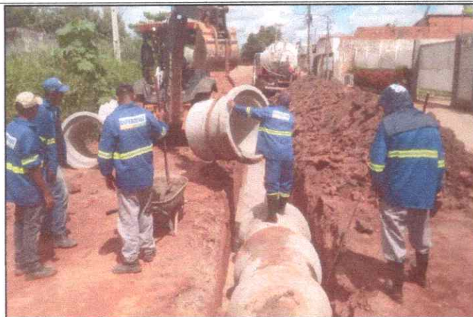
Foto 19 - AV. SÃO SEBASTIÃO - VILA NOVA - TUBO DE CONCRETO ARMADO PA2 - D= 0,80 M.
