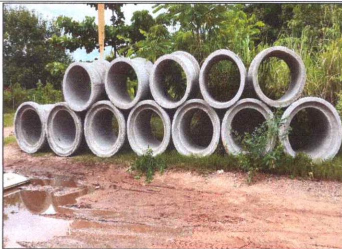
Foto 3 - AV. SÃO SEBASTIÃO - VILA NOVA - TUBO DE CONCRETO ARMADO PA2 - D= 0,80 M.
