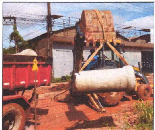
Foto 28 - AV. SÃO SEBASTIÃO - VILA NOVA - TUBO DE CONCRETO ARMADO PA2 - D= 0,40 M.
