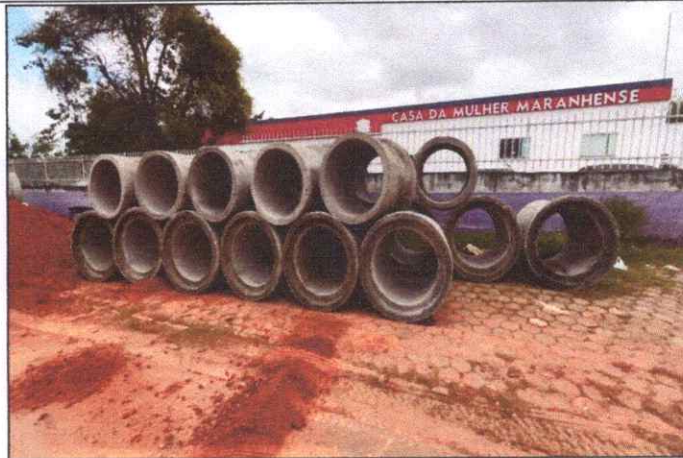
Foto 6 - AV. SÃO SEBASTIÃO - VILA NOVA - TUBO DE CONCRETO ARMADO PA2 - D= 0,80 M.
