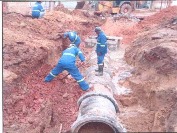
Foto 36 - AV. SÃO SEBASTIÃO - VILA NOVA - TUBO DE CONCRETO ARMADO PA2 - D= 0,80 M.
