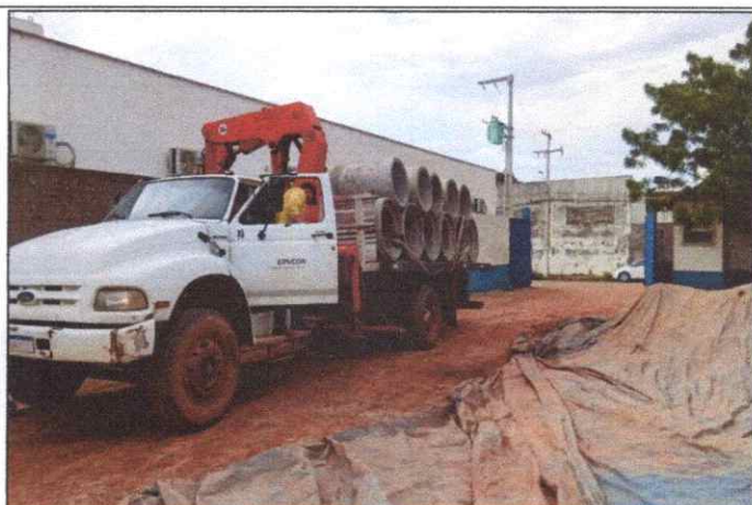
Foto 16 - SINFRA - TUBO DE CONCRETO ARMADO PA2 - D= 0,60 M.
