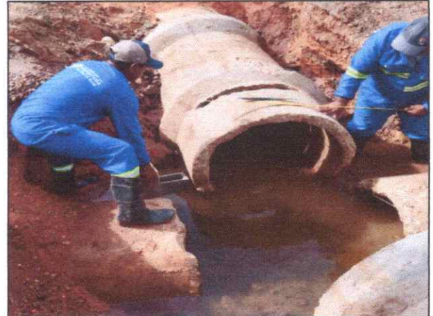
Foto 26 - AV. SÃO SEBASTIÃO - VILA NOVA - TUBO DE CONCRETO ARMADO PA2 - D= 0,80 M.
