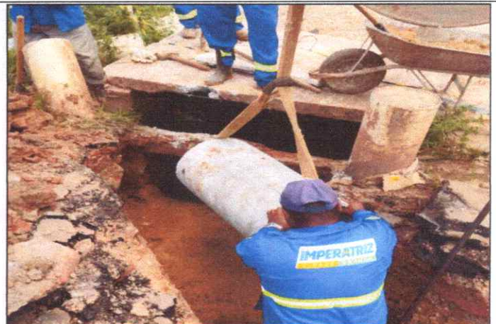
Foto 22 - R. MONTEVIDEO - VILA JOÃO CASTELO - TUBO DE CONCRETO ARMADO PA2 - D= 0,60 M.
