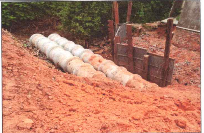
Foto 18 - R. SETE DE SETEMBRO - BACURI - TUBO DE CONCRETO ARMADO PA2 - D= 0,80 M.
