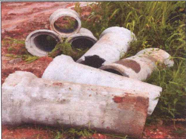
Foto 29 - AV. SÃO SEBASTIÃO - VILA NOVA - TUBO DE CONCRETO ARMADO PA2 - D= 0,40 M.
