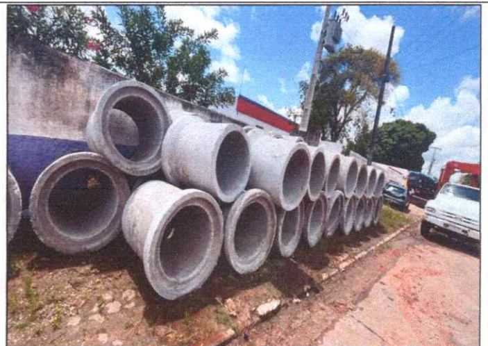
Foto 4 - AV. SÃO SEBASTIÃO - VILA NOVA - TUBO DE CONCRETO ARMADO PA2 - D= 0,80 M.
