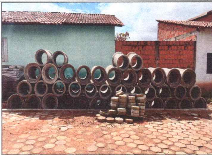
Foto 1 - R. GUILHERME CORTEZ – OURO VERDE - TUBO DE CONCRETO ARMADO PA2 - D= 0,40 M.
