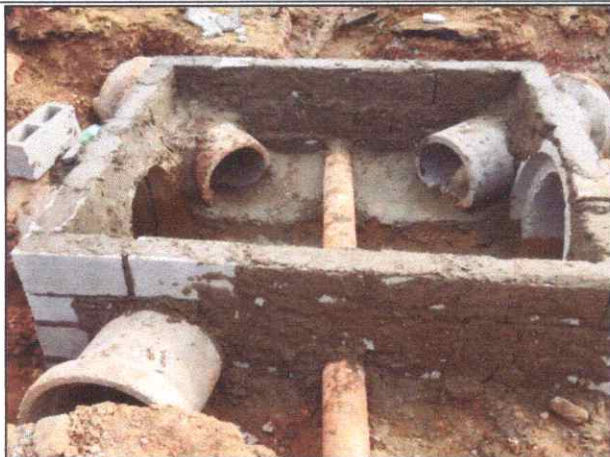
Foto 31 - AV. SÃO SEBASTIÃO - VILA NOVA - TUBO DE CONCRETO ARMADO PA2 - D= 0,80 M E D= 0,40 M.
