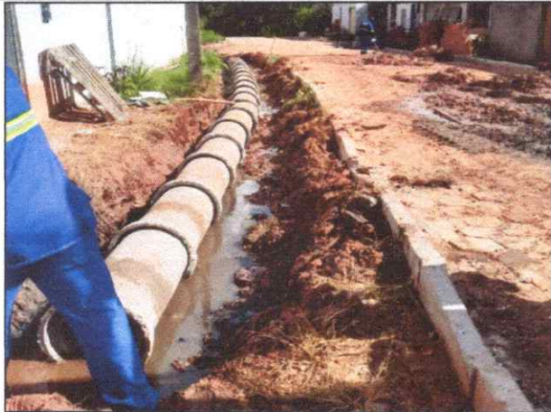
Foto 25 - R. ALFA – OURO VERDE - TUBO DE CONCRETO ARMADO PA2 - D= 0,40 M / MEIO FIO DE CONCRETO 80 CM.
