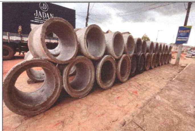
Foto 14 - AV. SÃO SEBASTIÃO - VILA NOVA - TUBO DE CONCRETO ARMADO PA2 - D= 0,80 M.
