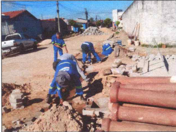
Foto 41 - R. PERIMETRAL CASTELO BRANCO – PARQUE BURITI – BLOQUETE HEXAGONAL SEXTAVADO 25X25X8.
