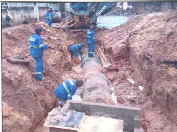
Foto 35 - AV. SÃO SEBASTIÃO - VILA NOVA - TUBO DE CONCRETO ARMADO PA2 - D= 0,80 M.
