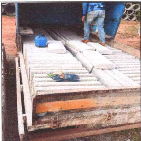
Foto 11 - SINFRA – MEIO FIO DE CONCRETO 80 CM.
