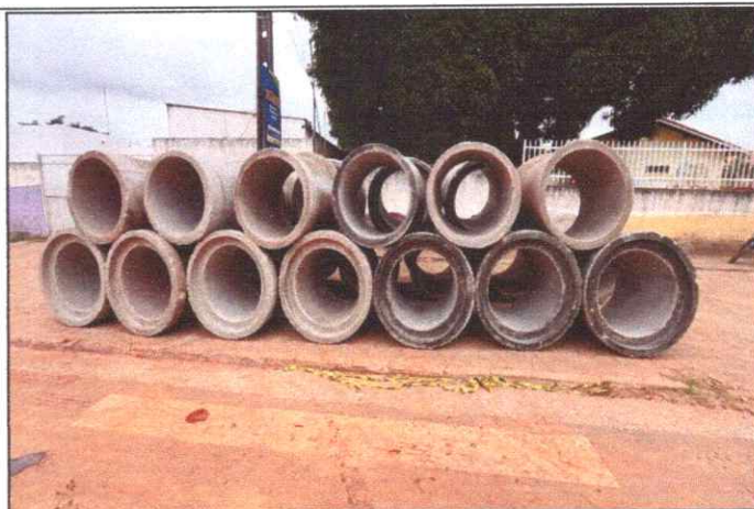
Foto 12 - AV. SÃO SEBASTIÃO - VILA NOVA - TUBO DE CONCRETO ARMADO PA2 - D= 0,80 M.
