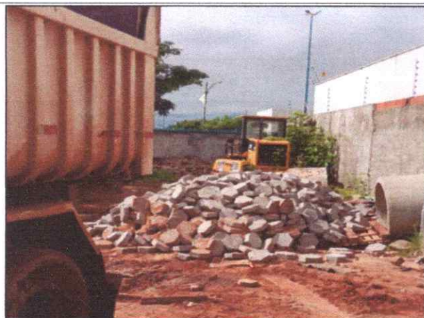
Foto 39 - SINFRA - BLOQUETE HEXAGONAL SEXTAVADO 25X25X8.
