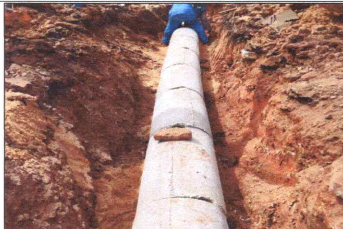
Foto 21 - AV. LIBERDADE - VILA JOÃO CASTELO - TUBO DE CONCRETO ARMADO PA2 - D= 0,60 M.
