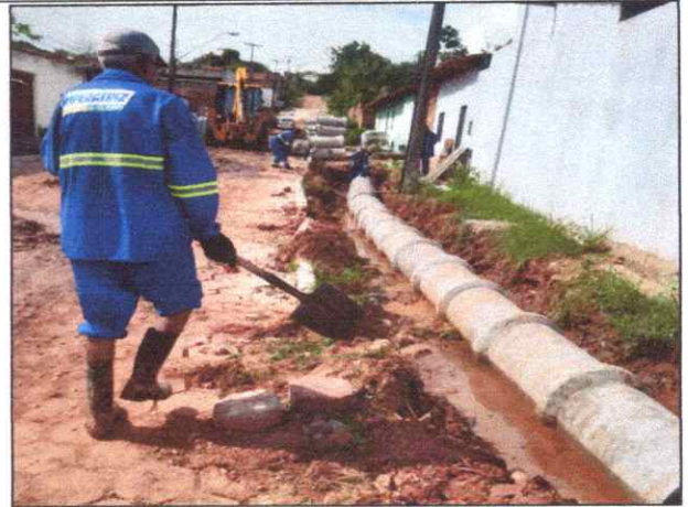
Foto 24 - R. ALFA – OURO VERDE - TUBO DE CONCRETO ARMADO PA2 - D= 0,40 M.
