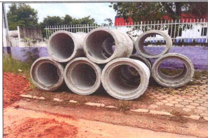
Foto 5 - AV. SÃO SEBASTIÃO - VILA NOVA - TUBO DE CONCRETO ARMADO PA2 - D= 0,80 M.
