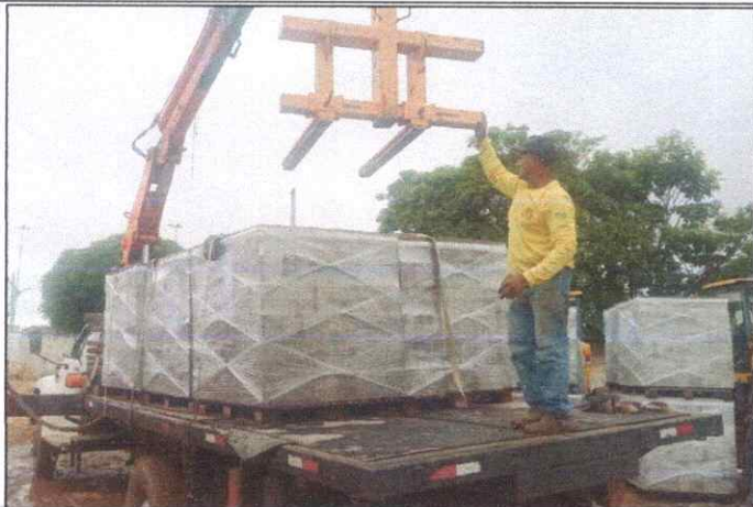
Foto 5 - BLOCO DE CONCRETO ESTRUTURAL 19X19X39 CM, FBK 10 MPA.
