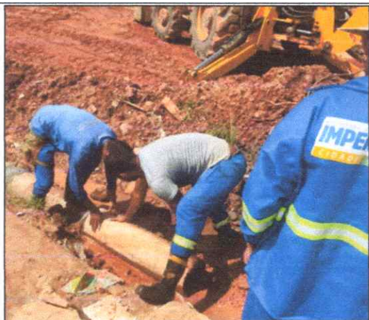
Foto 35 - TUBO DE CONCRETO ARMADO PA2 - D= 0,40 M.
