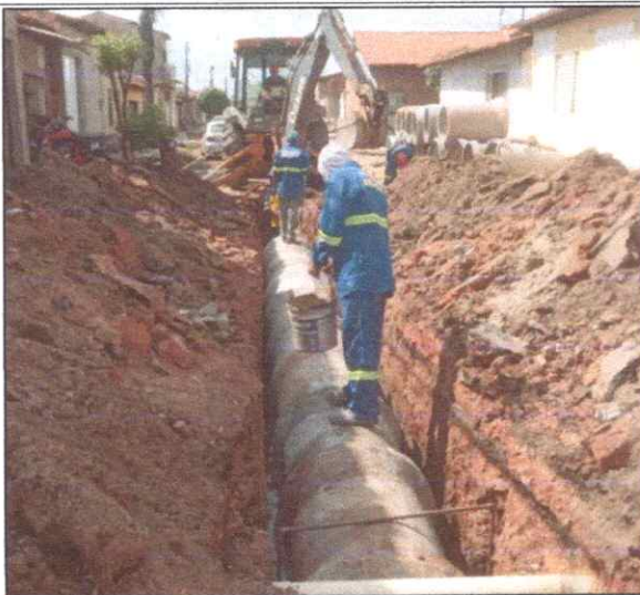
Foto 33 - TUBO DE CONCRETO ARMADO PA2 - D= 0,80 M.
