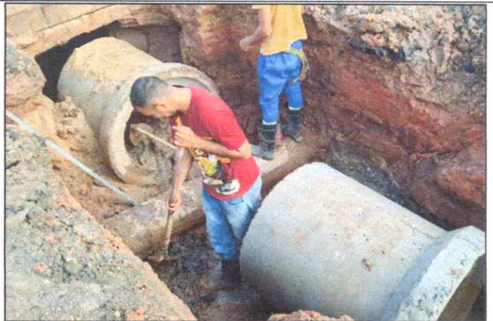
Foto 18 - TUBO DE CONCRETO ARMADO PA2 - D= 0,80 M.
