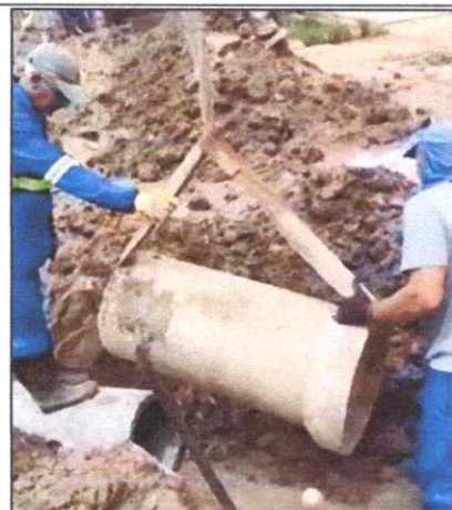
Foto 8 - TUBO DE CONCRETO ARMADO PA2 - D= 0,60.
