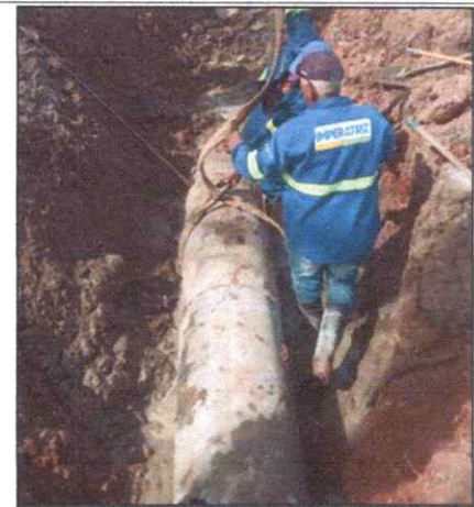
Foto 14 - TUBO DE CONCRETO ARMADO PA2 - D= 0,60 M.
