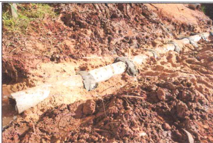
Foto 36 - TUBO DE CONCRETO ARMADO PA2 - D= 0,40 M.
