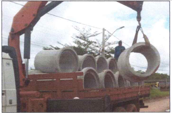
Foto 20 - TUBO DE CONCRETO ARMADO PA2 - D= 1,00 M.
