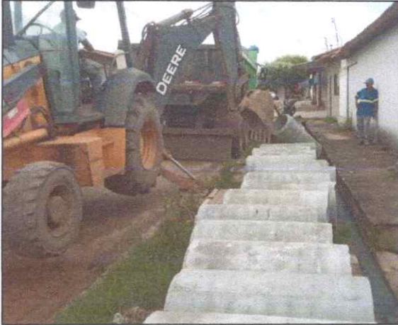
Foto 41 - TUBO DE CONCRETO ARMADO PA2 - D= 0,60 M.
