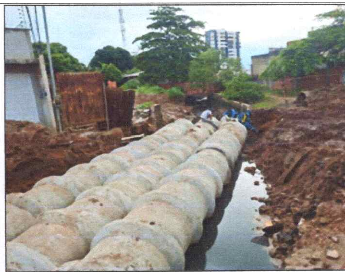
Foto 4 - TUBO DE CONCRETO ARMADO PA2 - D= 1,00 M.
