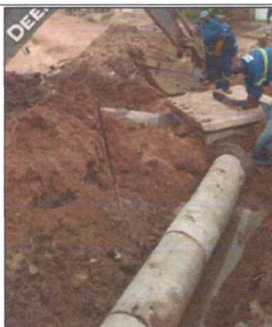
Foto 9 - TUBO DE CONCRETO ARMADO PA2 - D= 0,40.
