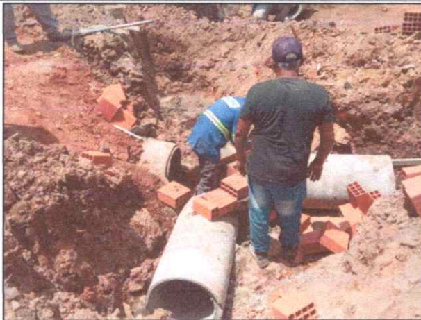
Foto 13 - TUBO DE CONCRETO ARMADO PA2 - D= 0,60 M.
