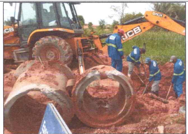
Foto 16 - TUBO DE CONCRETO ARMADO PA2 - D= 0,80 M.
