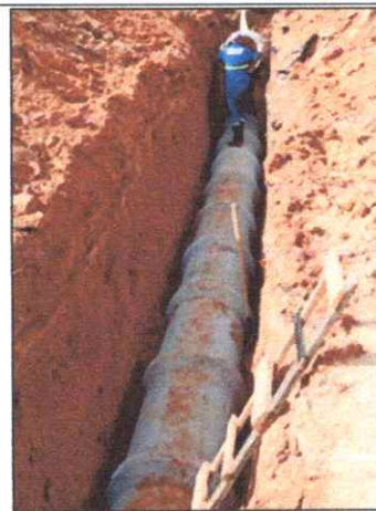
Foto 28 - TUBO DE CONCRETO ARMADO PA2 - D= 0,60 M.
