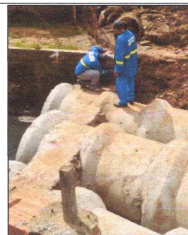
Foto 10 - TUBO DE CONCRETO ARMADO PA2 - D= 1,00 M
