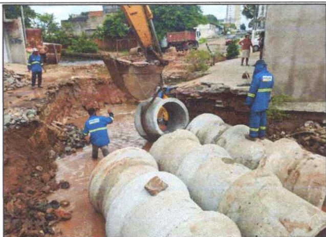
Foto 37 - TUBO DE CONCRETO ARMADO PA2 - D= 1,20 M.
