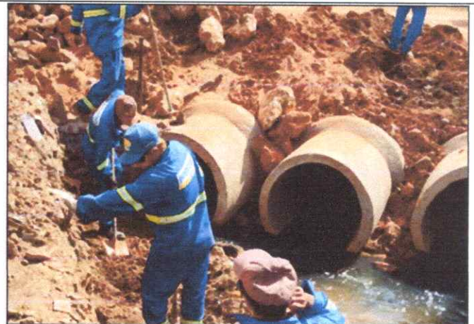
Foto 12 - TUBO DE CONCRETO ARMADO PA2 - D= 1,00 M.
