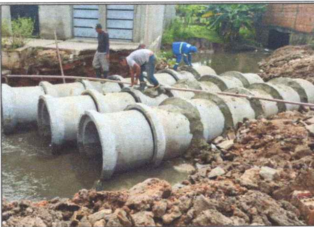
Foto 39 - TUBO DE CONCRETO ARMADO PA2 - D= 1,20 M.
