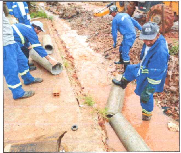
Foto 34 - TUBO DE CONCRETO ARMADO PA2 - D= 0,40 M.
