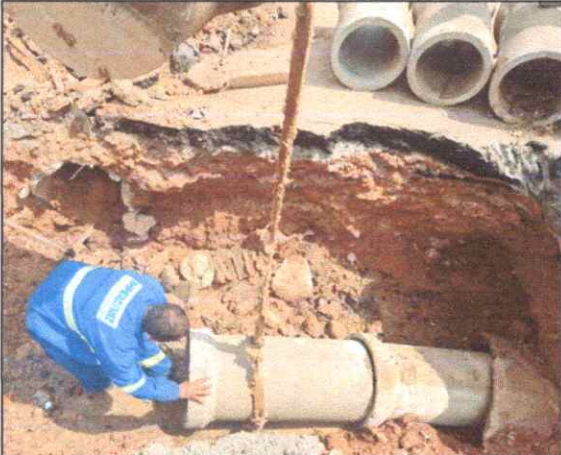
Foto 29 - TUBO DE CONCRETO ARMADO PA2 - D= 0,60 M.
