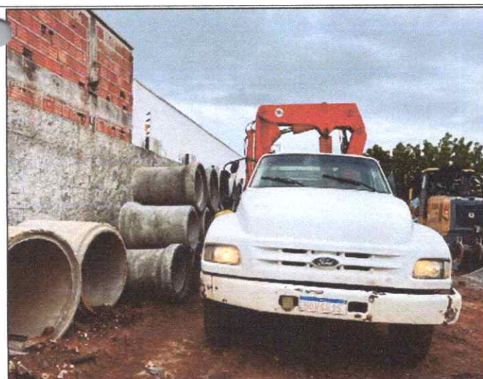
Foto 3 - TUBO DE CONCRETO ARMADO PA2 - D= 0,80 M.
