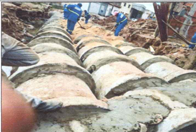
Foto 7 - TUBO DE CONCRETO ARMADO PA2 - D= 1,00 M.
