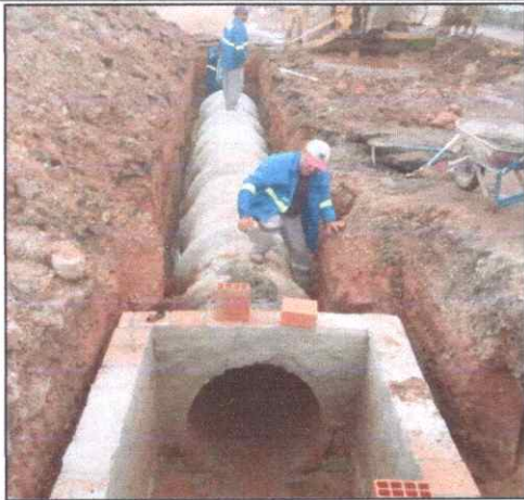
Foto 19 - TUBO DE CONCRETO ARMADO PA2 - D= 0,80 M.
