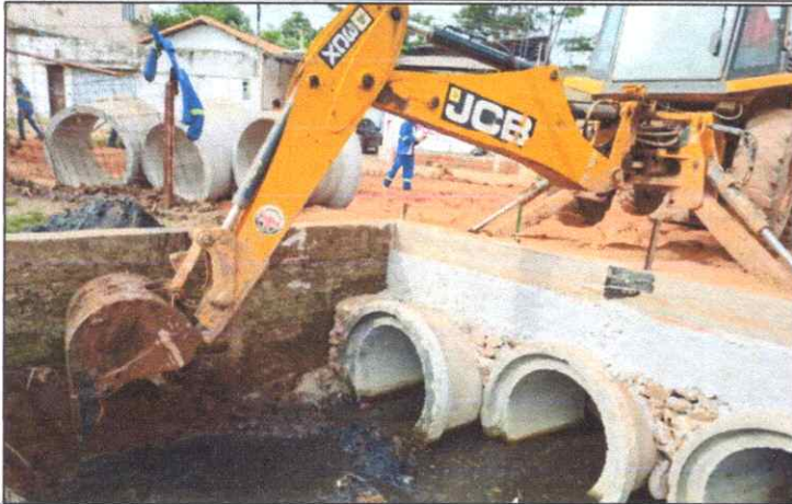
Foto 11 - TUBO DE CONCRETO ARMADO PA2 - D= 1,00 M.
