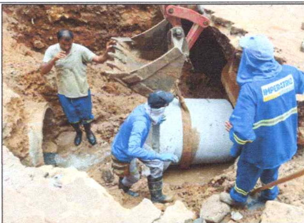
Foto 15 - TUBO DE CONCRETO ARMADO PA2 - D= 0,80 M.
