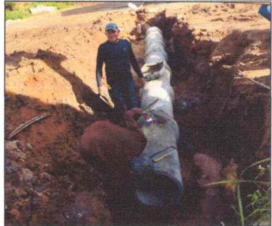
Foto 42 - TUBO DE CONCRETO ARMADO PA2 - D= 0,60 M.
