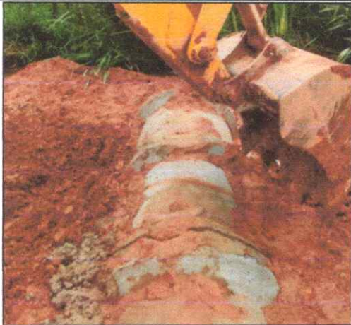
Foto 17 - TUBO DE CONCRETO ARMADO PA2 - D= 0,80 M.
