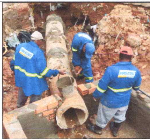
Foto 38 - TUBO DE CONCRETO ARMADO PA2 - D= 0,60 M.
