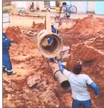
Foto 32 - TUBO DE CONCRETO ARMADO PA2 - D= 0,80 M.
