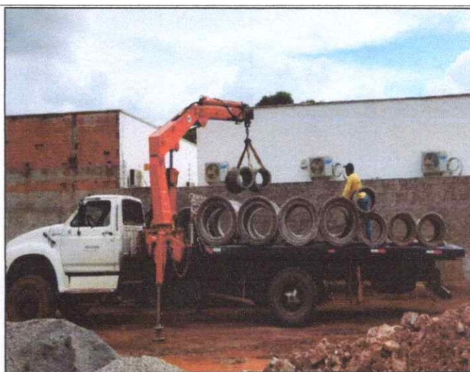
Foto 2 - TUBO DE CONCRETO ARMADO PA2 - D= 0,40 M e D=0,60
