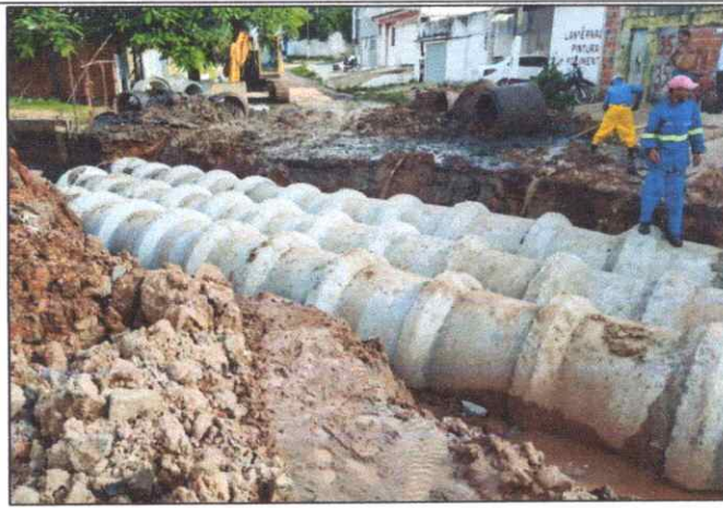
Foto 40 - TUBO DE CONCRETO ARMADO PA2 - D= 1,20 M.
