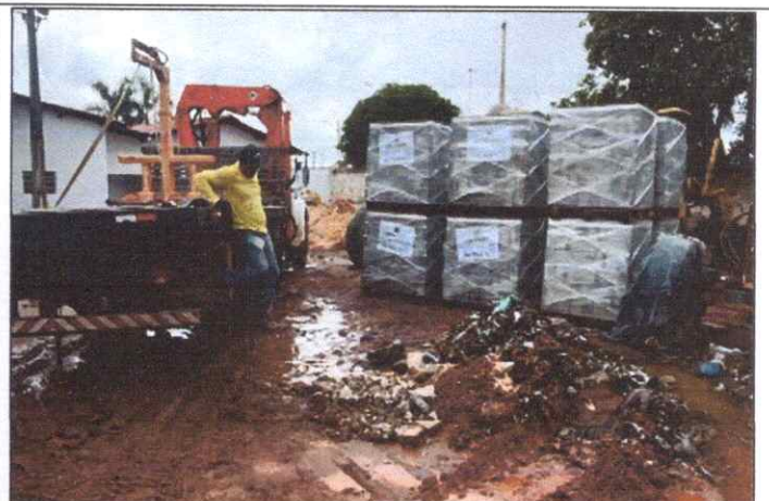
Foto 6 - BLOCO DE CONCRETO ESTRUTURAL 19X19X39 CM, FBK 10 MPA.
