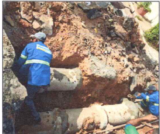
Foto 30 - TUBO DE CONCRETO ARMADO PA2 - D= 0,60 M.
