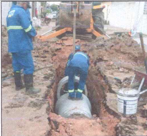
Foto 31 - TUBO DE CONCRETO ARMADO PA2 - D= 0,80 M.
