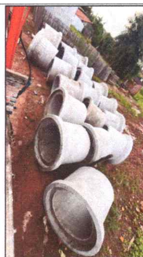
Foto 2 - R. MANOEL RIBEIRO SOARES. PROX. ANEL VIÁRIO - TUBO DE CONCRETO ARMADO PA2 - D= 1,00 M.
