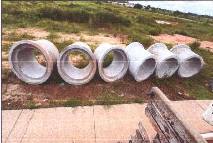
Foto 5 - AV. PRINCIPAL 01 - PQ. INDEPENDENCIA - TUBO DE CONCRETO ARMADO PA2 - D= 1,00 M.
