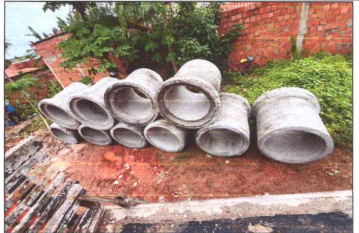
Foto 6 - R. SETE DE SETEMBRO – BACURI - TUBO DE CONCRETO ARMADO PA2 - D= 0,80 M.
