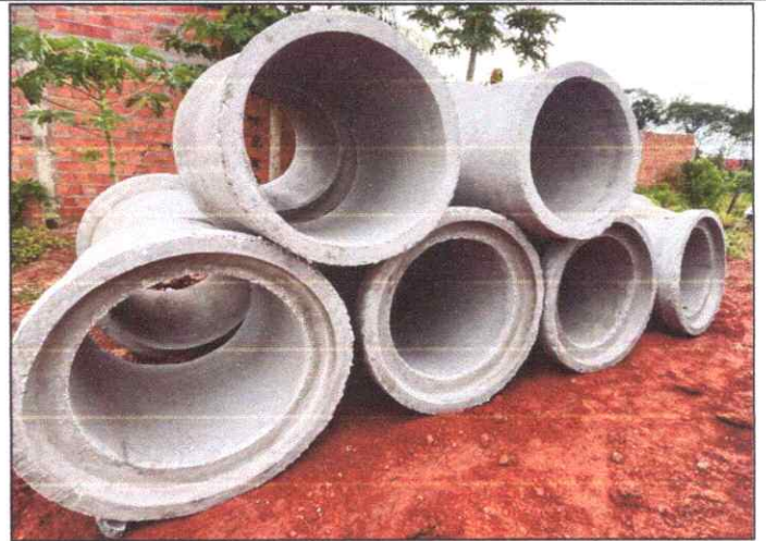
Foto 8 - R. SETE DE SETEMBRO – BACURI - TUBO DE CONCRETO ARMADO PA2 - D= 0,80 M.
