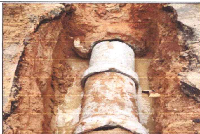
Foto 27 - R. SANTA TEREZA – CENTRO - TUBO DE CONCRETO ARMADO PA2 - D= 0,40 M.
