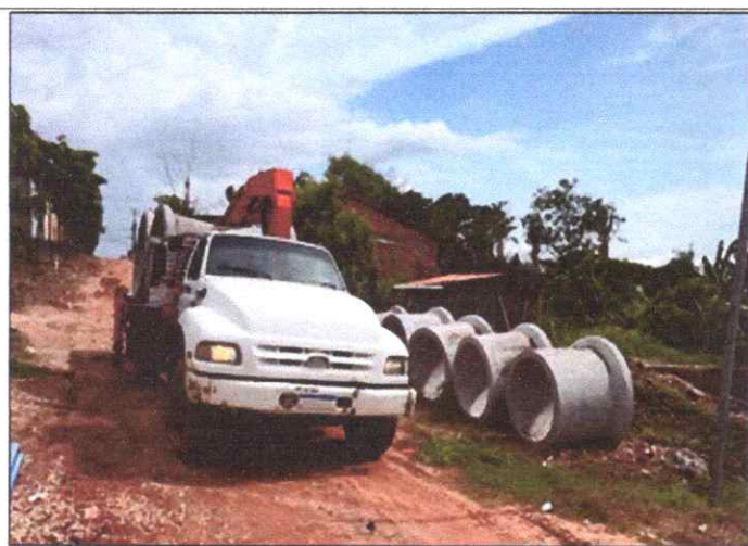
Foto 1 - R. MANOEL RIBEIRO SOARES. PROX. ANEL VIÁRIO - TUBO DE CONCRETO ARMADO PA2 - D= 1,00 M.
