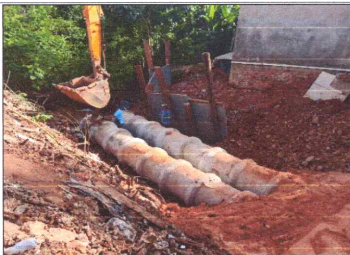
Foto 11 - R. SETE DE SETEMBRO - BACURI - TUBO DE CONCRETO ARMADO PA2 - D= 0,80 M.
