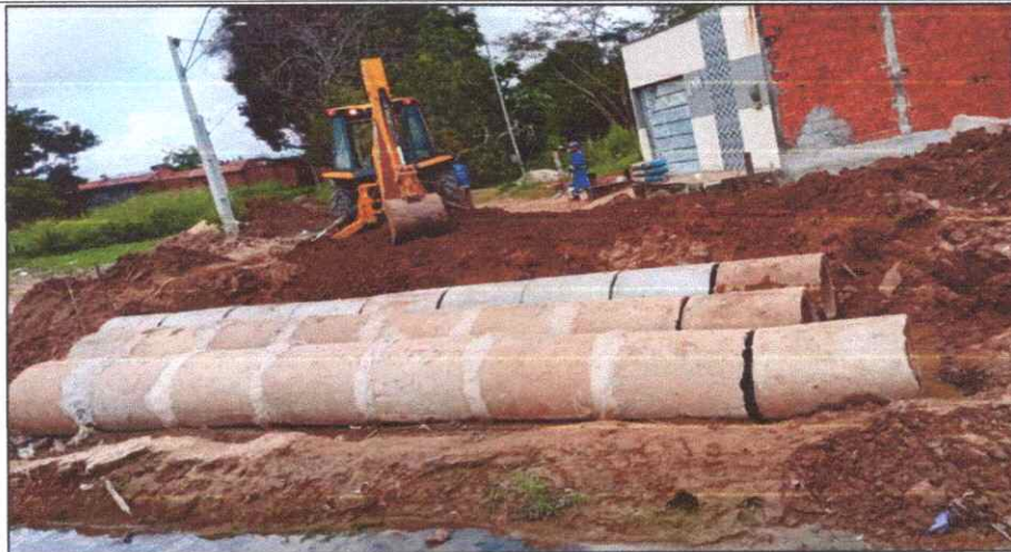
Foto 34 - R. 22 – SOL NASCENTE - TUBO DE CONCRETO ARMADO PA2 - D= 1,00 M.
