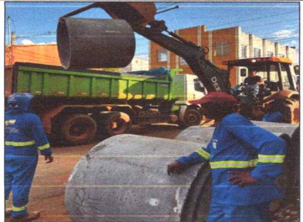
Foto 33 - R. TUPINAMBÁ - BACURÍ - TUBO DE CONCRETO ARMADO PA2 - D= 1,00 M.
