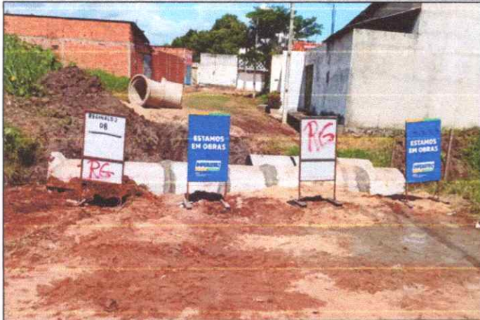
Foto 32 – VILINHA - TUBO DE CONCRETO ARMADO PA2 - D= 1,00 M.
