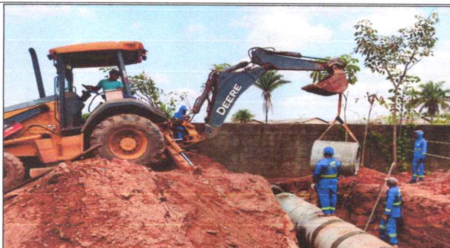
Foto 36 - R. ALFA – OURO VERDE - TUBO DE CONCRETO ARMADO PA2 - D= 0,80 M.
