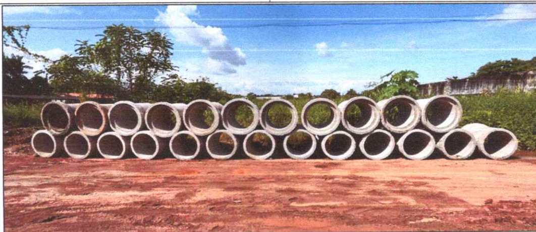
Foto 9 - AV. SÃO SEBASTIÃO - VILA NOVA - TUBO DE CONCRETO ARMADO PA2 - D= 0,80 M.
