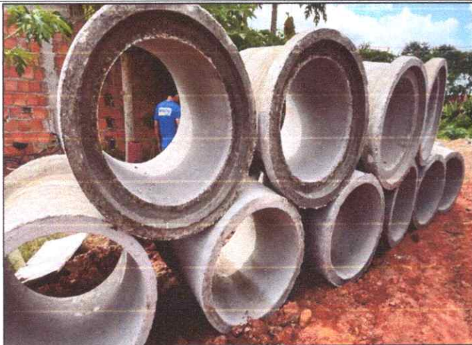
Foto 7 - R. SETE DE SETEMBRO – BACURI - TUBO DE CONCRETO ARMADO PA2 - D= 0,80 M.
