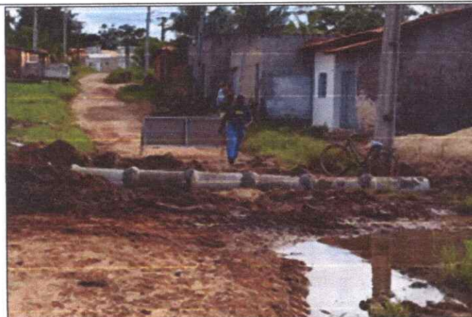
Foto 18 - RES. POR DO SOL - SANTA INÊS - TUBO DE CONCRETO ARMADO PA2 - D= 0,40 M.
