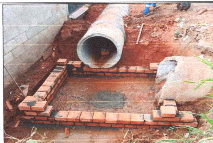
Foto 30 - AV. SILVINO SANTOS - IMIGRANTES - TUBO DE CONCRETO ARMADO PA2 - D= 0,60 M.
