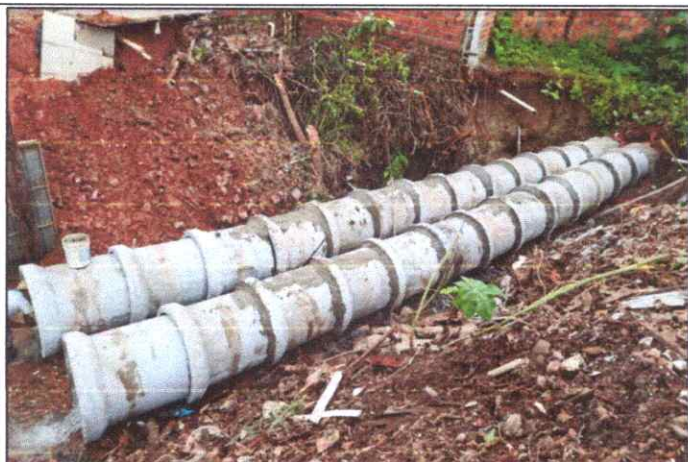
Foto 20 - R. SETE DE SETEMBRO – BACURI - TUBO DE CONCRETO ARMADO PA2 - D= 0,80 M.
