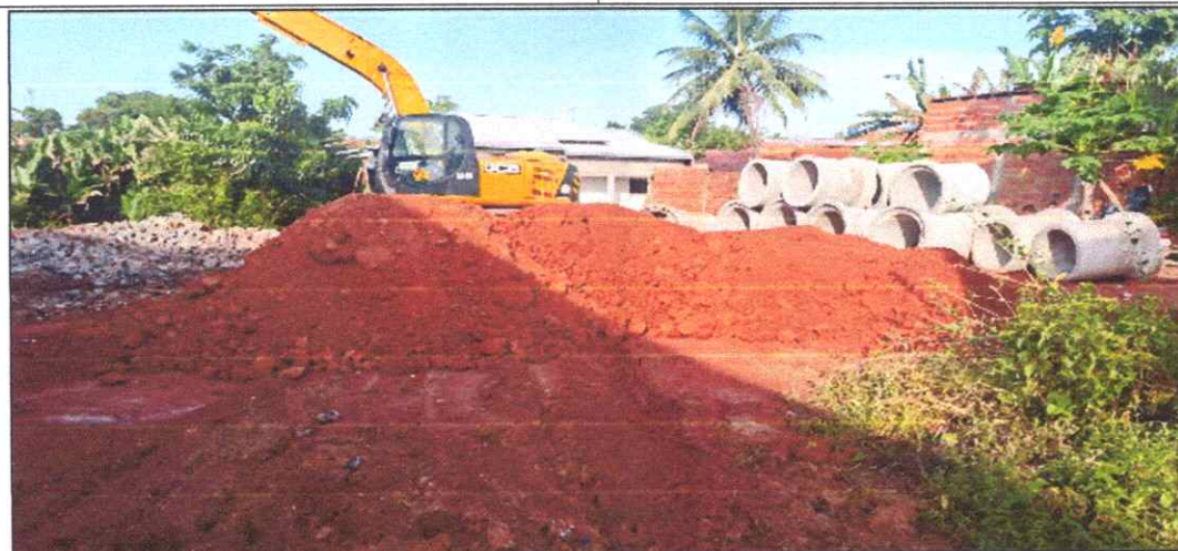
Foto 13 - R. SETE DE SETEMBRO - BACURI - TUBO DE CONCRETO ARMADO PA2 - D= 0,80 M.
