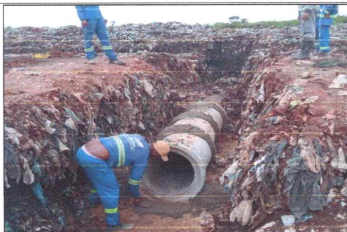
Foto 28 – LIXÃO MUNICIPAL - TUBO DE CONCRETO ARMADO PA2 - D= 0,60 M.
