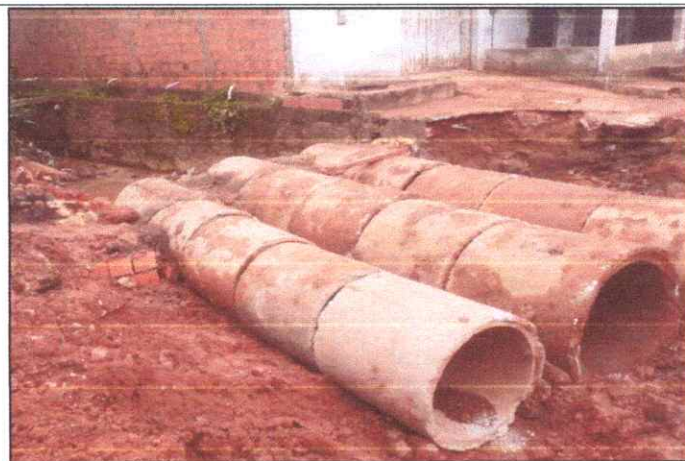
Foto 29 - AV. TIRADENTES - PQ SÃO JOSÉ - TUBO DE CONCRETO ARMADO PA2 - D= 1,00 M.
