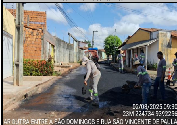
Rua Bilar Dutra - Bairro Parque São José
