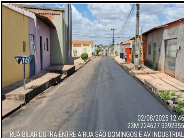
Rua Bilar Dutra - Bairro Parque São José
