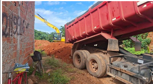
Foto 07 DRENAGEM RUA 7 PARQUE ANHANGUERA
