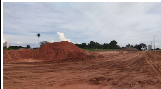
Foto 05 | TERRAPLANAGEM ACESSO AO BAIRRO SANTA INES
