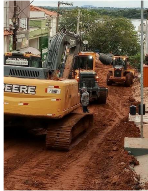
Foto 08 TERRAPLANAGEM GONÇALVES DIAS BEIRA RIO
