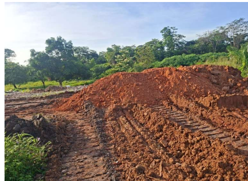
Foto 04 | DRENAGEM RUA 7 PARQUE ANHANGUERA
