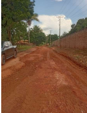
Foto 09 TERRAPLANAGEM JARDIM POR DO SOL
