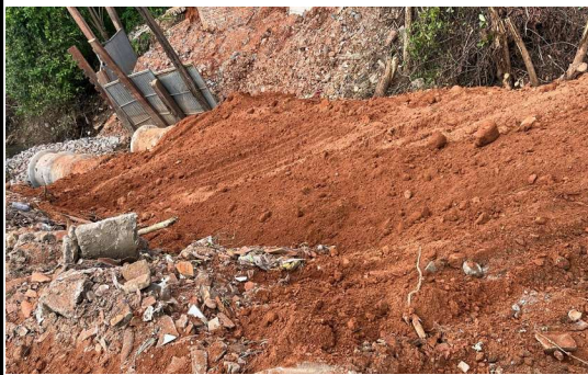
Foto 03 | DRENAGEM RUA 7 PARQUE ANHANGUERA
