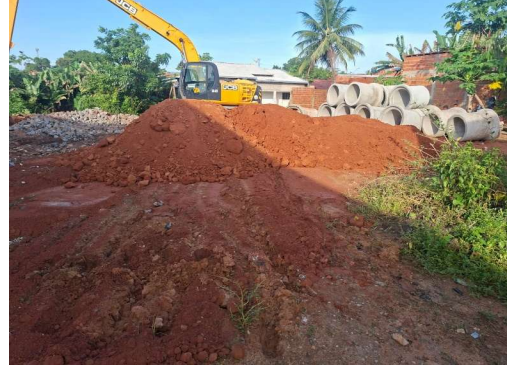
Foto 02 | DRENAGEM RUA 7 PARQUE ANHANGUERA
