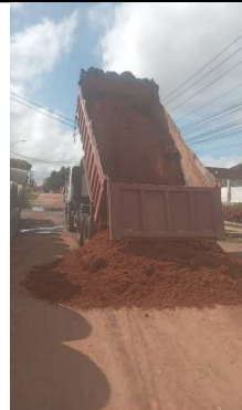
Foto 06 | DRENAGEM AV. SÃO SEBASTIÃO VILA NOVA
