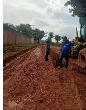
Foto 10 TERRAPLANAGEM JARDIM POR DO SOL
